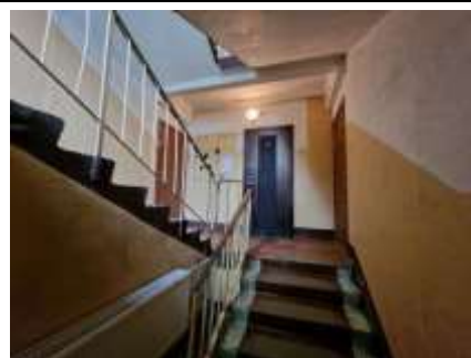
1.stāva kāpņu telpa
